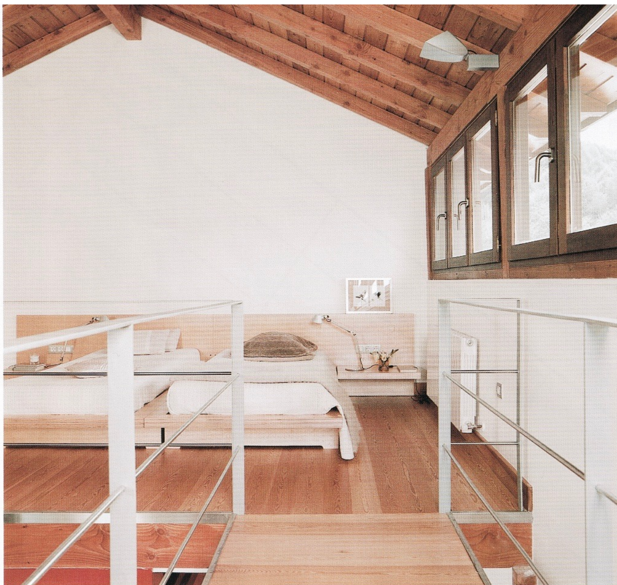
JUEGO DE MATERIALES. La zona de descanso se ha pavimentado con tarima de madera de alerce, el mismo material empleado en la cubierta. Tanto la escalera de acceso como la planta superior se han protegido con balaustre y pasamanos de llanta de hierro.
