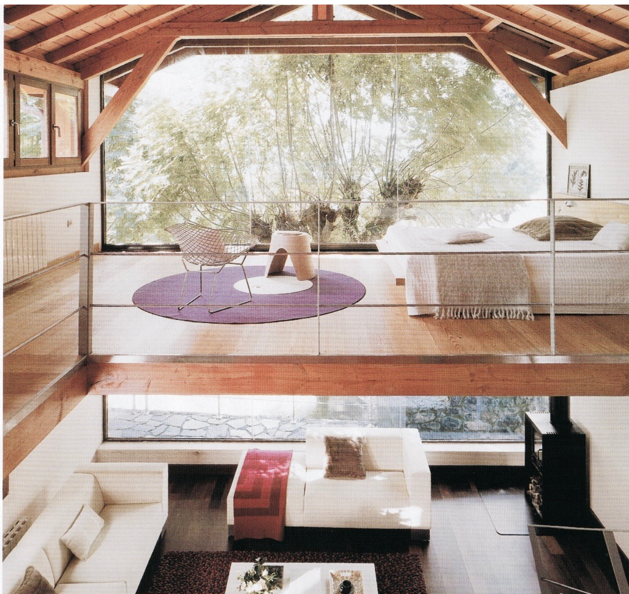
A DOS ALTURAS. La cubierta, rehabilitada con madera de pino alerce, se ha colocado a mayor altura que el techo original, con el fin de aumentar la entrada de luz natural al interior y, a la vez, ganar espacio en la planta bajo cubierta, donde se ubica la zona de descanso.
